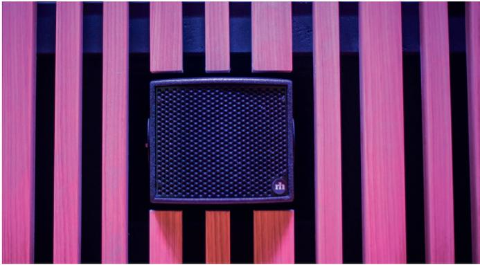
**Lautsprecher:** Nach Bearbeitung im Amadeus-Prozessor werden die Signale des Raums über 62 Lautsprecher in den Saal abgegeben
