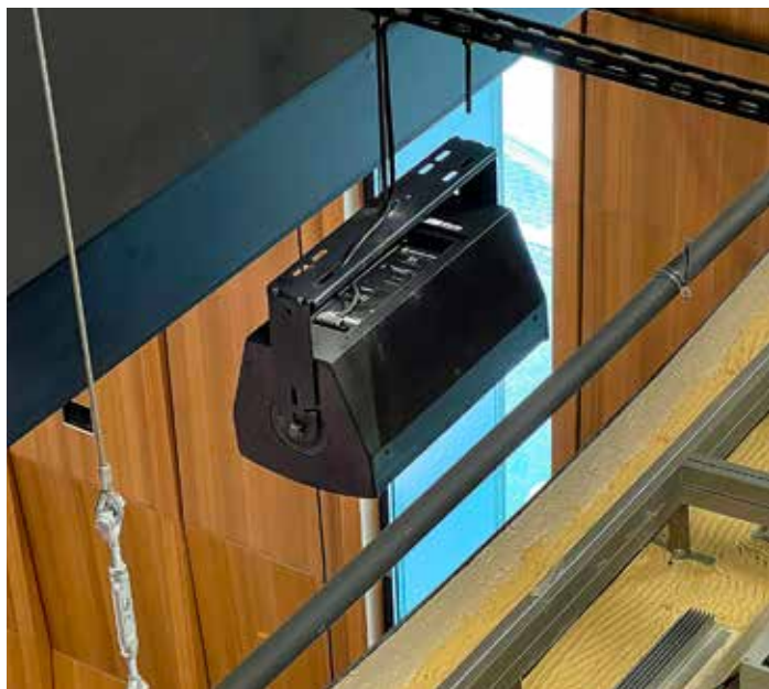
Renkus-Heinz-CX81-Lautsprecher zwischen den Deckensegeln der Vilco. Foto: MediasPro Medientechnik GmbH
